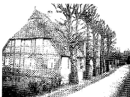
Alte strohbedeckte Bauernkaten auf der einen Seite der Dorfstraße...
