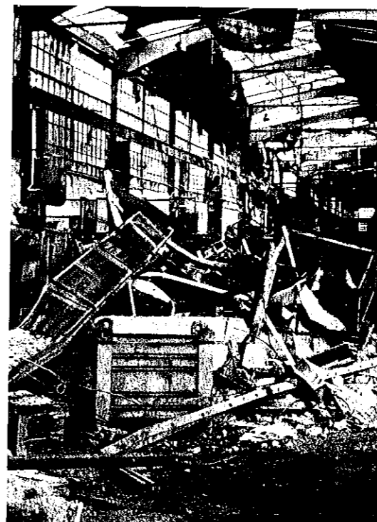
Das zerstörte Automobilwerk Zastava
