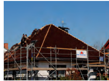
Profis auf dem Dach
