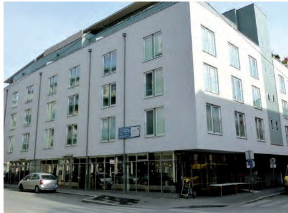
Wohnungsbau in Hamburg
