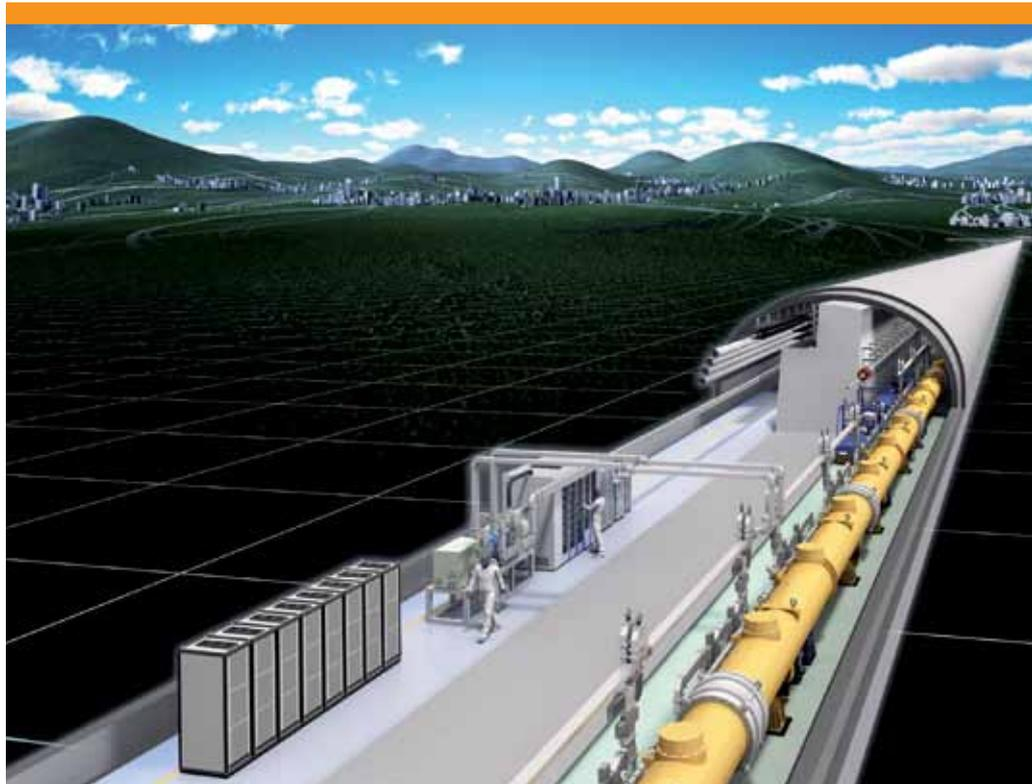
Eine Mittelwand aus Beton trennt den Beschleuniger vom Infrastrukturbereich. Illustration: Rey Hori/KEK
