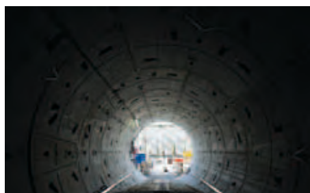
Blick in die zukünftige Experimentierhalle und eine Tunnelröhre des European XFEL
