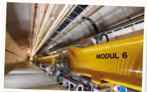
Die fertigen Module werden in den Beschleuniger eingebaut.
