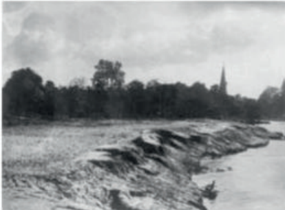
Der Winterhuder Kai während des Umbaus
