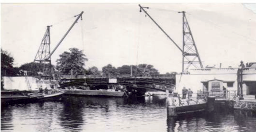
Winterhuder Brücke während des Neubaus
