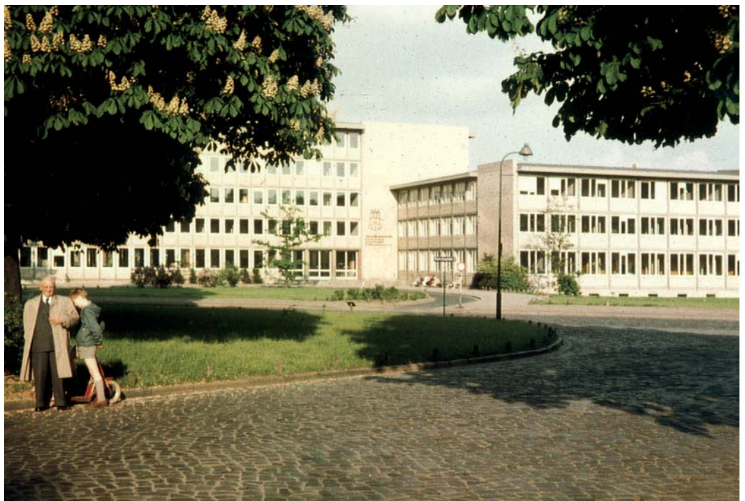
Der frühere Reinckeplatz um 1962, im Hintergrund das Bezirksamt Hamburg-Nord. Dieser Platz fiel dem Ausbau des Ring 2 zum Opfer. Foto: Isi Werner
