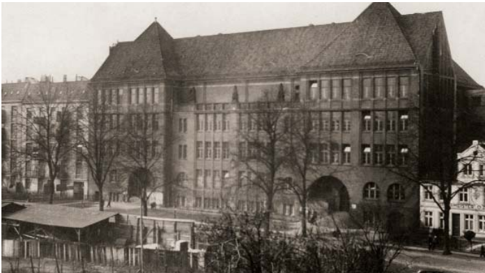
Das Schulgebäude schloss 1910 die letzte Baulücke im unteren Teil der Ericastraße — einzig der gegenüberliegende Straßenabschnitt blieb bis in die 50er Jahre hinein nur teilweise bebaut.
