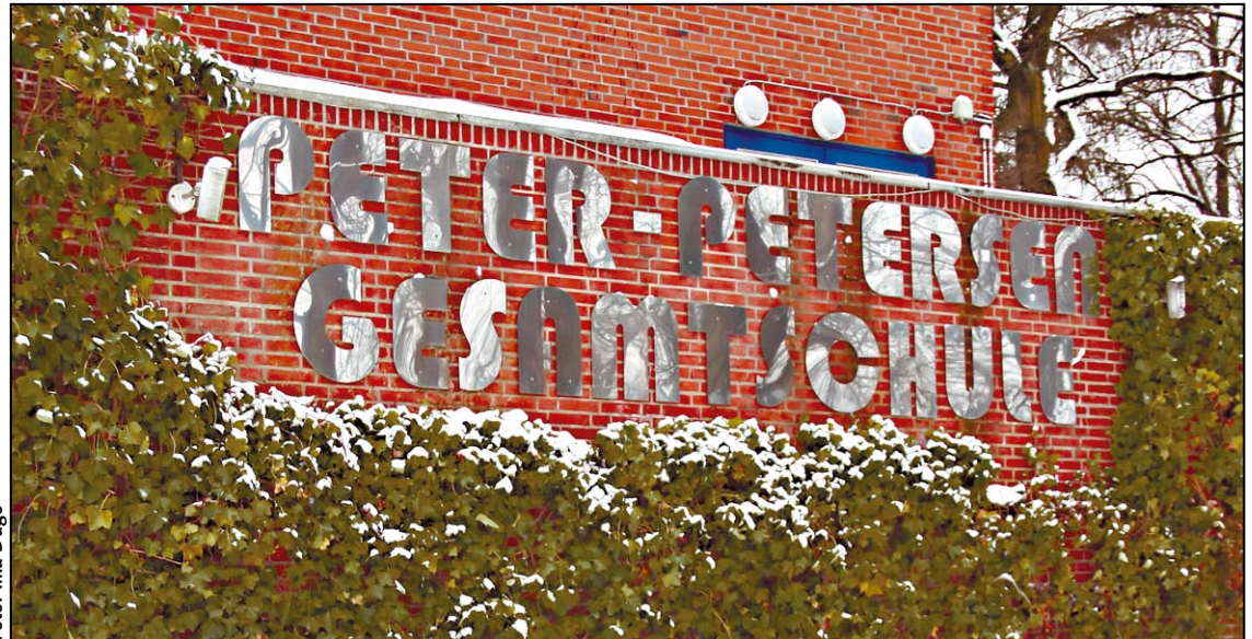
Wird bald einen neuen Schriftzug bekommen: das Gebäude der PPS am Pfeilshof
