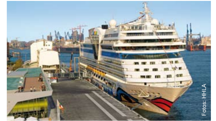
Am Altonaer terminal wird der Landstromanschluss gebaut
