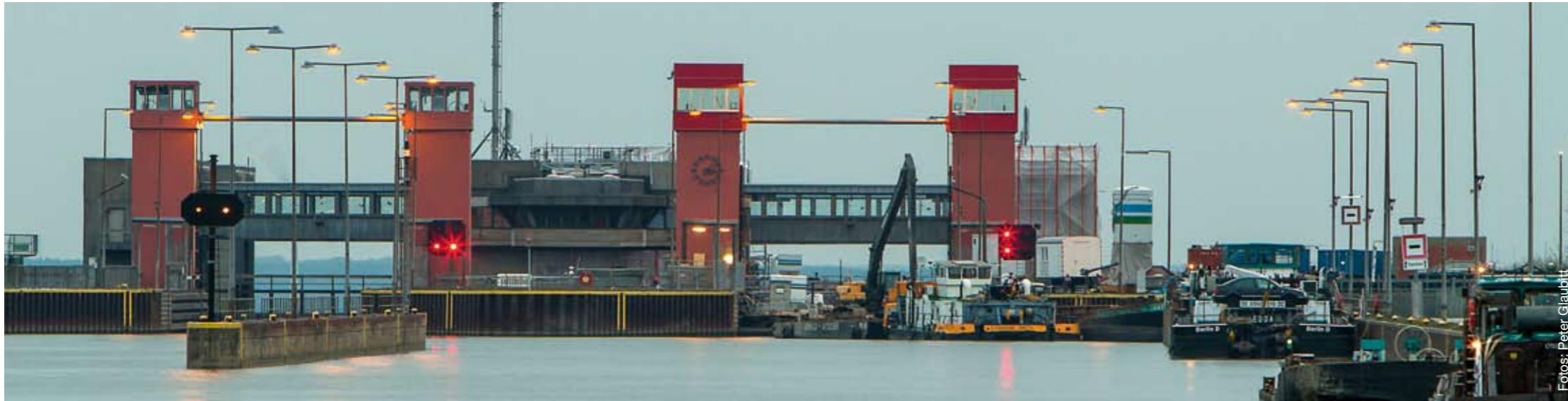
Das Schiffshebewerk Scharnebeck ist für die modernen Großbinnenschiffe unterdimensioniert und war in den letzten Jahren störanfällig
