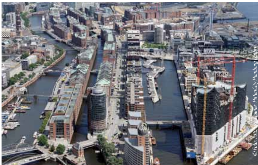
Der Traditionsschiffhafen im Sandtorhafen stellt den Mittelpunkt des städtebaulichen Ensembles am Sandtorkai / Dalmannkai dar. An der Spitze ist die Elbphilharmonie im Bau.
