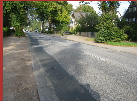
Straßensanierungen werden fortgesetzt
