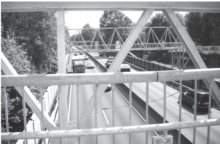
Blick von der neuen barrierefreien Fußgängerbrücke auf die Deltabrücke. Beide überbrücken die jetzige Reichsstraße. Für die igs wurden ein Lärmschutz gebaut und Flüsterasphalt verlegt. Eigentlich könnte die Straße jetzt so bleiben ... Foto: MG
