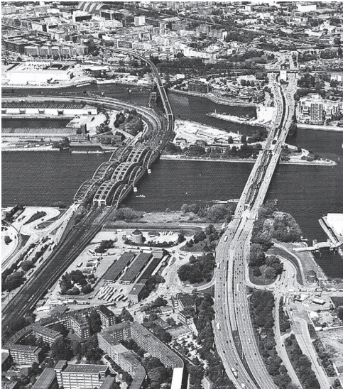
Der Deich Veddel Nord zwischen den Norderelbbrücken. Abb.: LSBG
