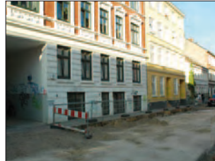
Blick in die aufgerissene Zeistrae
