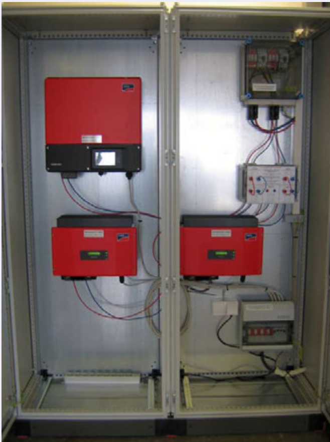
Bild 3a (links): Schaltschrank mit Netzwechselrichter Oben: Zentralwechselrichter Unten: Strangwechselrichter
