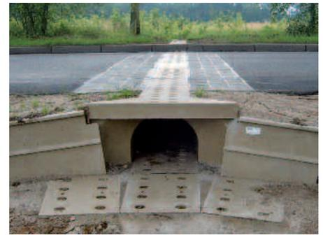
Untertunnelungen ermöglichen den Tieren eine sichere Straßenüberquerung [J. Mohrdieck]
