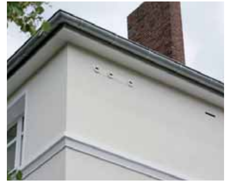
So einfach lassen sich bei der Dämmung eines Gebäudes Fledermauskästen in die neue Fassade einbauen. [Hermann Jansen]
