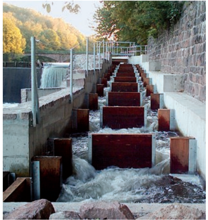
So oder ähnlich könnte eine Fischtreppe bei der Sanierung der Ernst-August-Schleuse realisiert werden. Nur will die zuständige Behörde einen derartigen Fischweg offensichtlich nicht.
