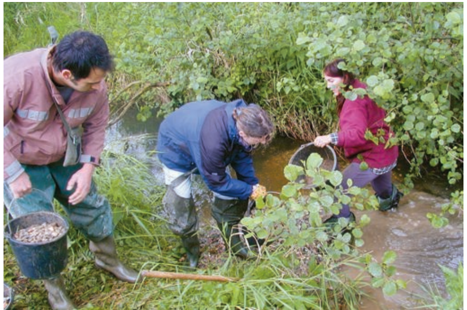
Einbringen von Feldsteinen als Strömungslenker.
