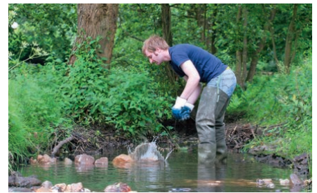
Einbringen von Feldsteinen als Strömungslenker.
