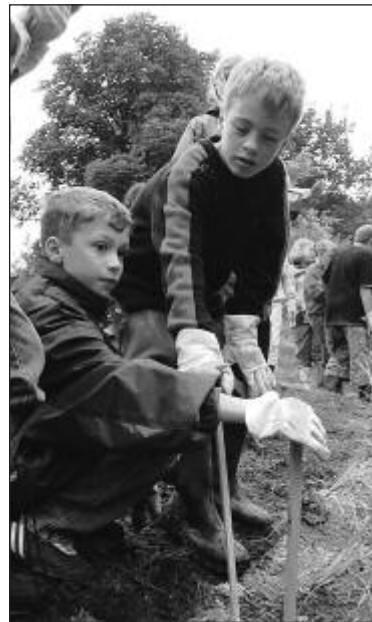
... befestigen sie anschließend mit Nägeln im Boden
