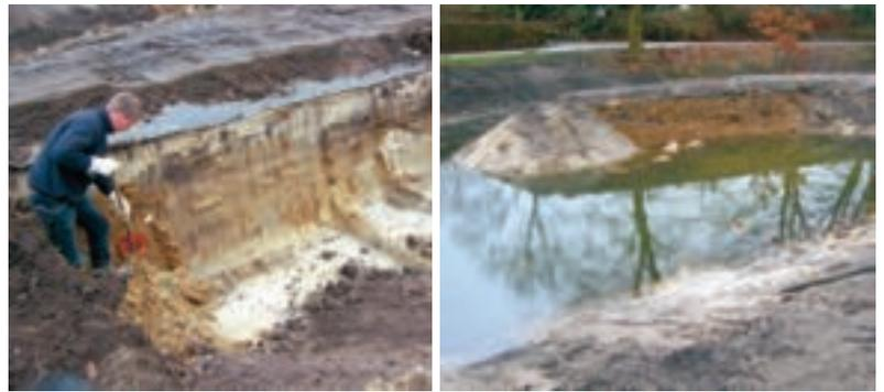
Der zuvor durch Befüllen einer Grube und anschließendes Verdichten entstandene Lehm/Sand/Kalk-Block wird freigegeben bis eine Steilwand oberhalb der Wasserlinie entstanden ist. Nun kann der Eisvogel einziehen.
