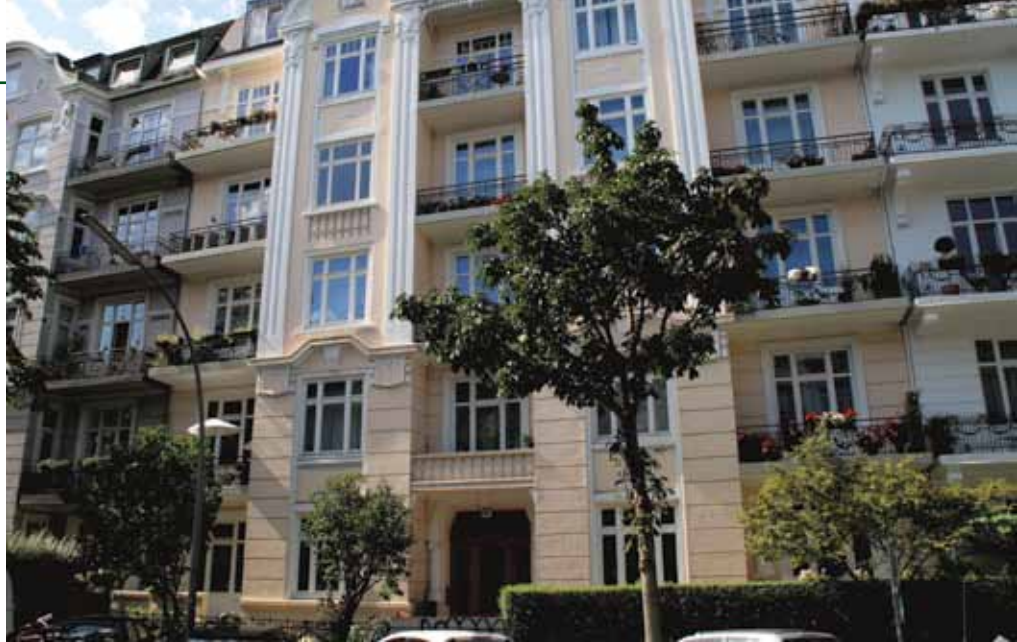
Nach Modernisierungsmaßnahmen stellen manche Vermieter überhöhte Forderungen, wie hier in der Isestraße 69 a. Foto: stahlpress
