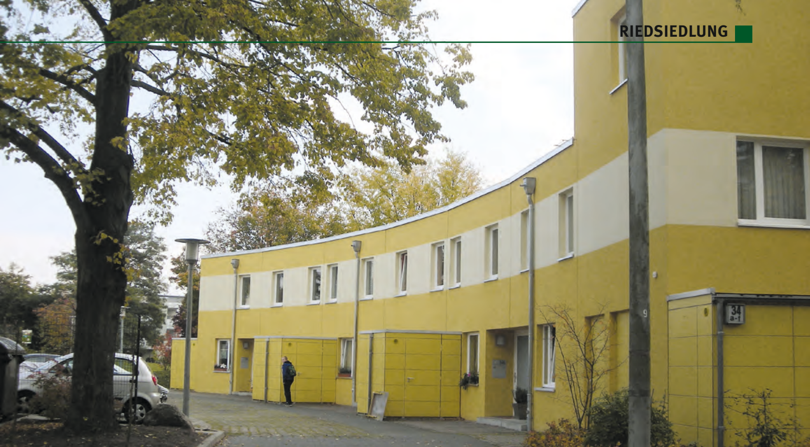
Die Riedsiedlung im gegenwärtigen Zustand. Die Bewohner fühlen sich wohl. Foto: Kreuzer
