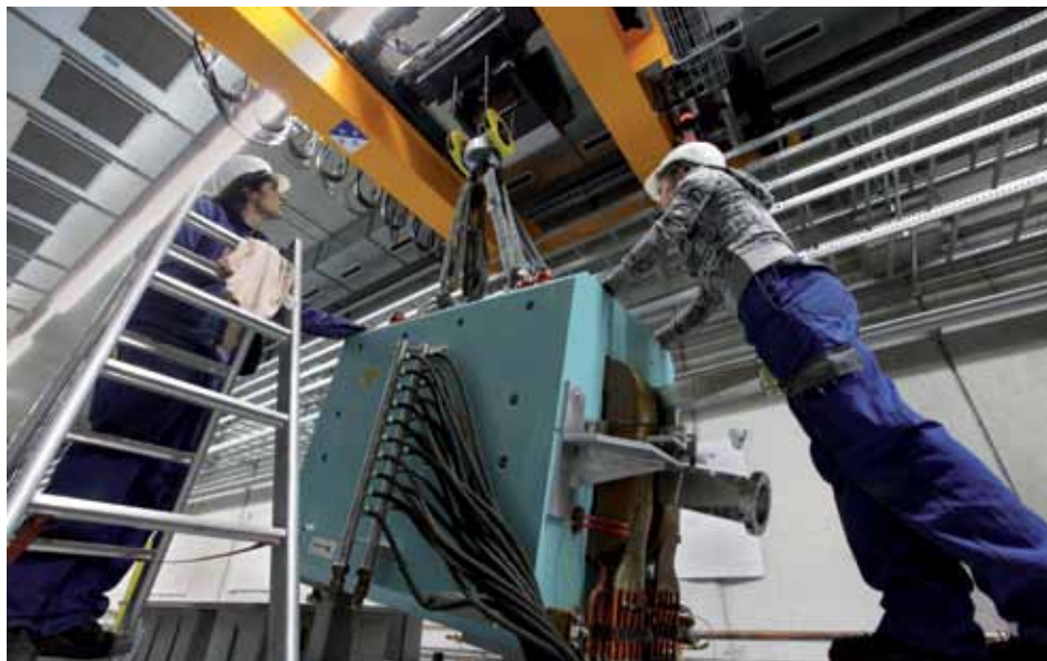
Der Dump-Magnet wird in FLASH2 montiert.
