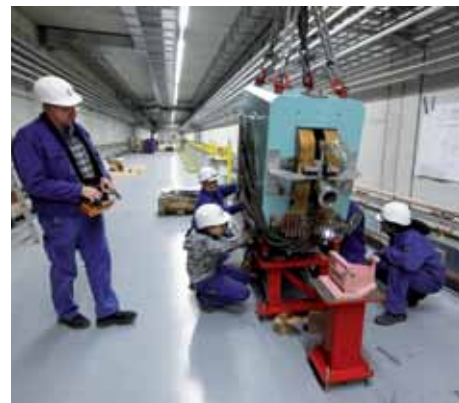
Der Dump-Magnet wird in FLASH2 montiert.
