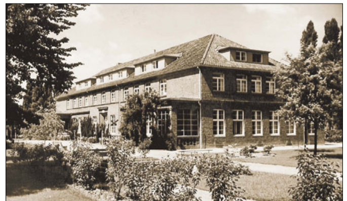
Auf dem Krankenhausesgelände an der Jüthornstraße wurde 1927 dieses Gebäude als Haus 6 errichtet. Archiv Fricke
