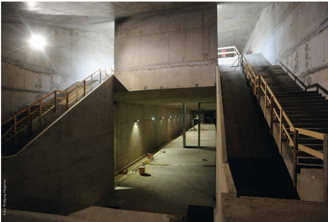
Die U-Bahnhaltestelle Überseequartier im Bau: Der Rohbau war über 20 Meter breit und 200 Meter lang.
