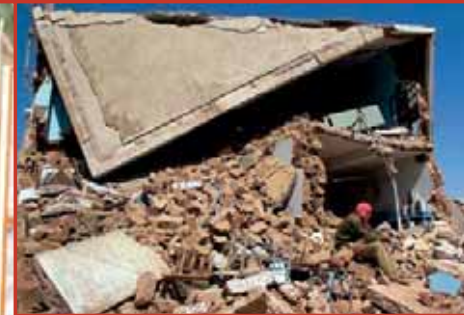
Das Erdbeben in Gujarat verwandelte Städte in Schuttberge
