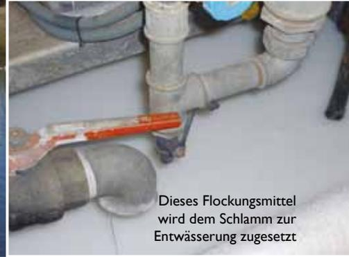
Dieses Flockungsmittel wird dem Schlamm zur Entwässerung zugesetzt
