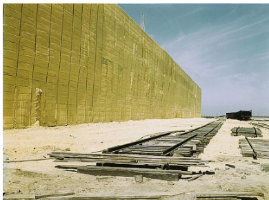
Meterhohe Mengen ungenutzten Schwefelabfalls lagern in Raffinerien.
