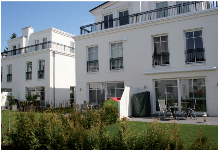
Ein positives Beispiel. Neubausiedlung an der Dockenhudener Straße auf dem ehemaligen Gelände einer Tankstelle. Die klassizistische Villa ist als Vorbild unverkennbar, ohne den Bauten die Aktualität zu nehmen.
