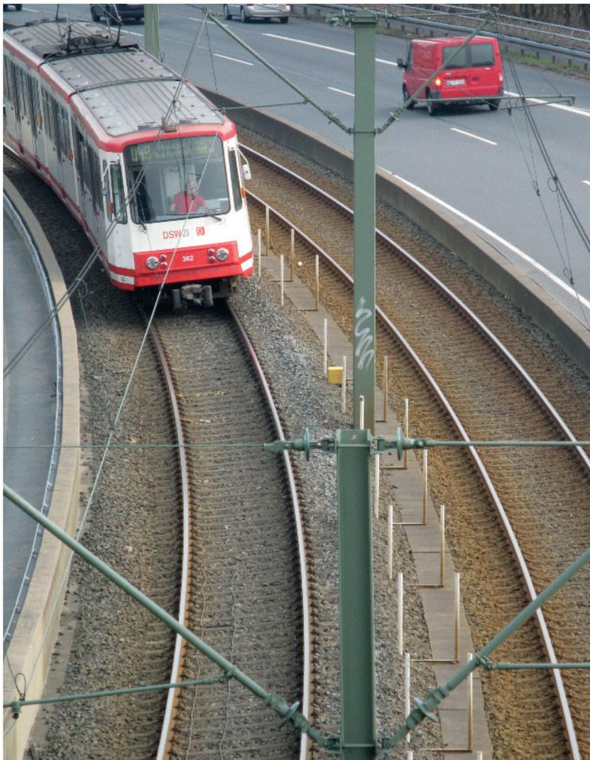
In dieser Gleisanlage ist der Sicherheitsraum zwischen den Gleisen angeordnet. Haltestangen verschaffen den Beschäftigten zusätzliche Sicherheit bei der Vorbeifahrt von Straßenbahnen.
