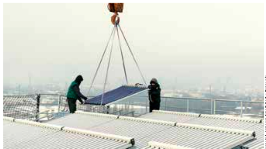
Baustelle am Energiebunker. Von der alten Kriegeruine zum innovativen Energieversorger.
