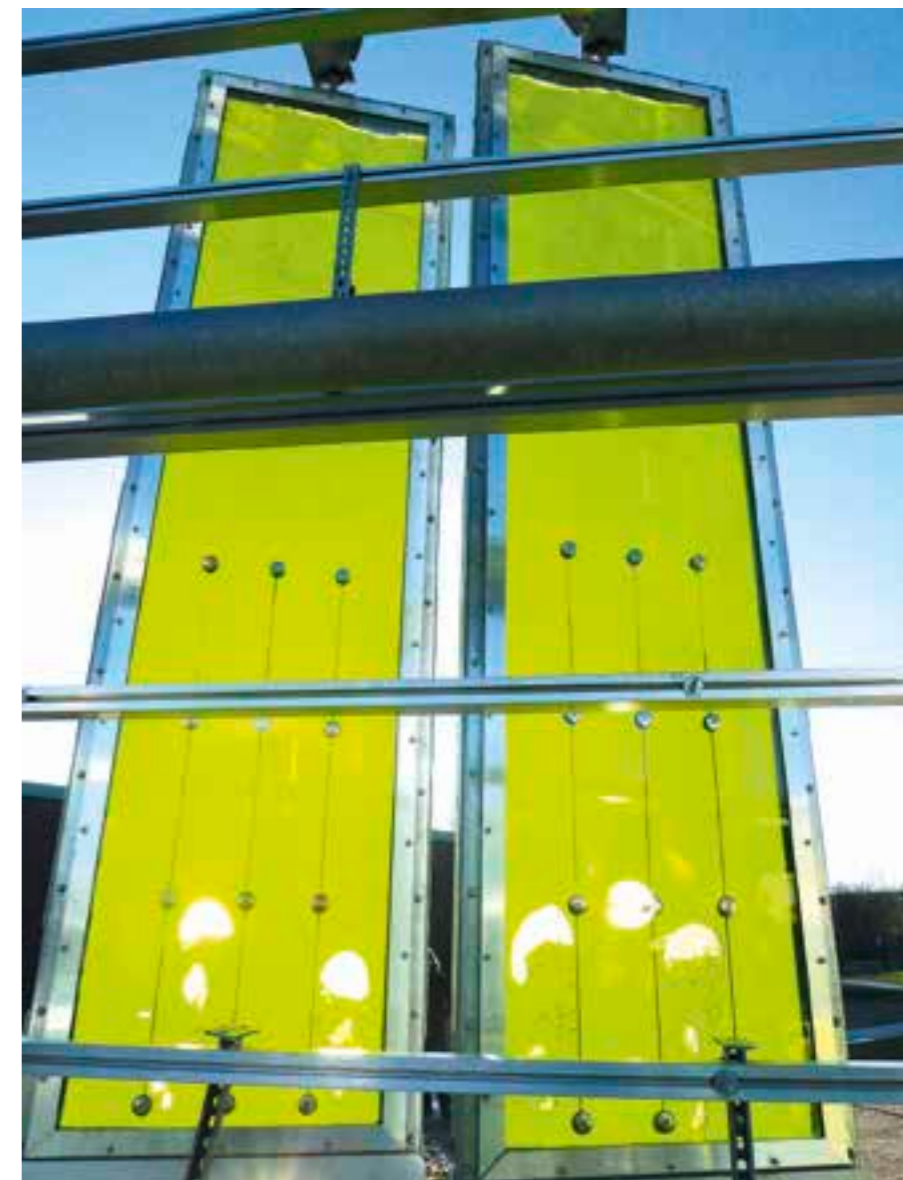
Ein Leuchtturmprojekt der IBA-Hamburg ist auch der Algenreaktor.
