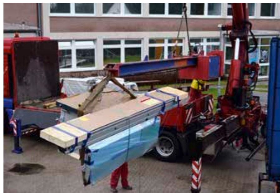
Millimeterarbeit: Per Kran schwebte die über eine Tonne schwere Formatkreissäge an ihren neuen Bestimmungsort in der Tischlerwerkstatt der BBK.
