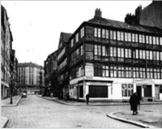
Das Foto zeigt an der Ecke rechts das Haus Peterstraße 28, heute Sitz der Geschäftsstelle der Carl-Toepfer-STIFTUNG, Blick Richtung Hütten. Das Bild zeigt die Situation, bevor Alfred Toepfer die Wohnanlage errichtete.
