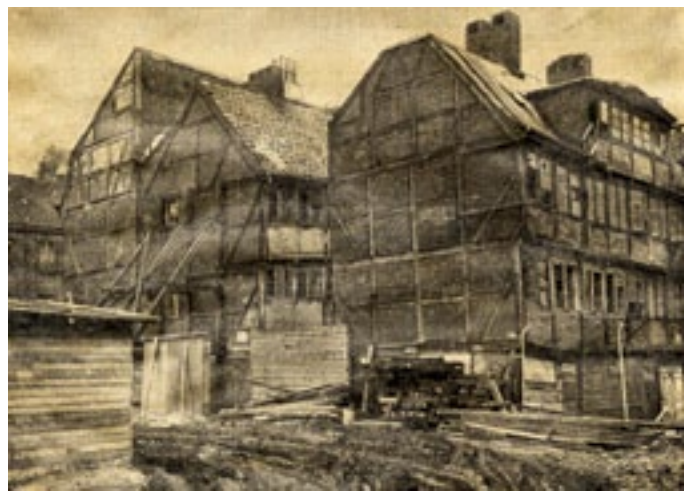
So sah es hinter dem Beyling-Stift aus, bevor Alfred Toepfer mit der Restaurierung begann. Die beiden Hinterhauszeilen waren stark verfallen und standen größtenteils leer.
