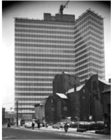
Foto: Bildarchiv Denkmalschutzamt
