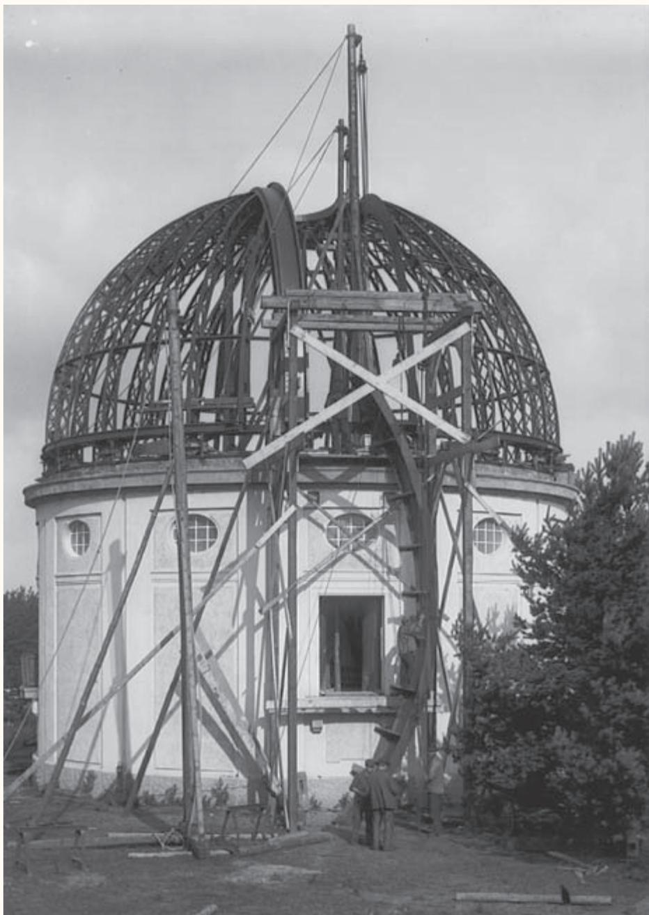
Im Juni 1909 begannen die Montagearbeiten für die Kuppel des Großen Refraktors. Die Eisenkonstruktion wurde von der Königin-Marien-Hütte in Cainsdorf bei Zwickau geliefert. Foto: Hamburger Sternwarte.
