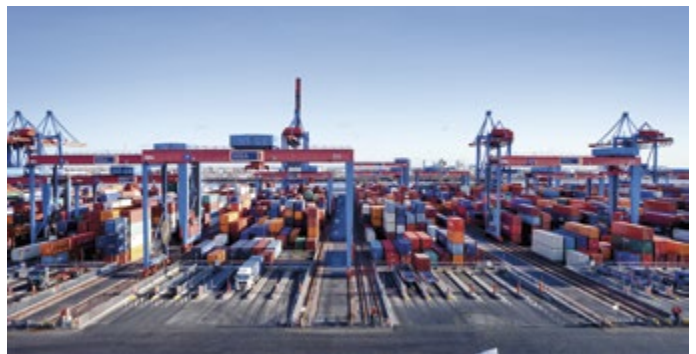
Mehr als 20 Mio. Standardcontainer hat der Betreiber HHLA seit Inbetriebnahme in Altenwerder umgeschlagen. Foto: HHLA.
