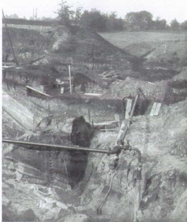
Abb. 13: Die Grundwasserabsenkungsanlage funktioniert einwandfrei, die Grabungsstelle ist trocken. (A. Rust 1937)
