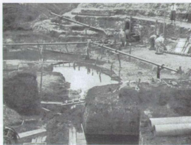
Abb. 12: Hauptgrabung Meiendorf (Md 2) vor der Inbetriebnahme der Grundwasserabsenkungsanlage (A. Rust 1937)
