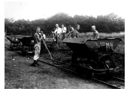
Abbildung 20: Der Arbeitsdienst bei Erdarbeiten, 1935
