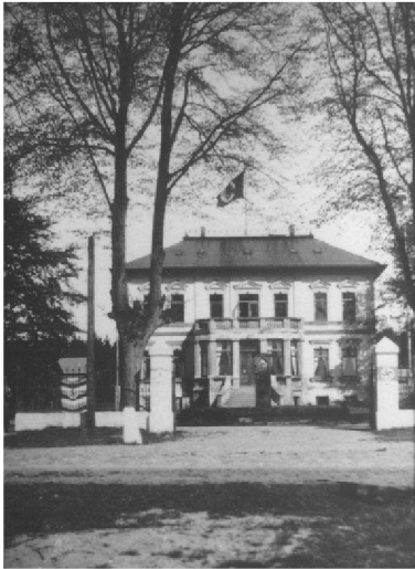
Abbildung 15: Einfahrt zum Lager des Arbeitsdienstes Höltigbaum
