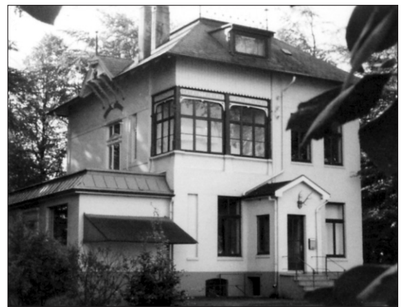
Abbildung 3: Haus Freienfelde, Rückansicht
