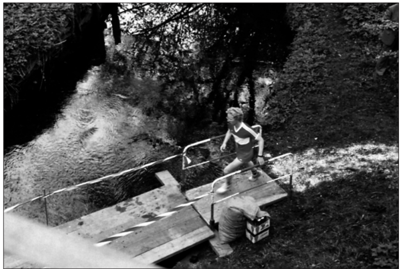
Abbildung 6: Behelfsbrücke über die Wandse unter der Bahnbrücke, 1987
