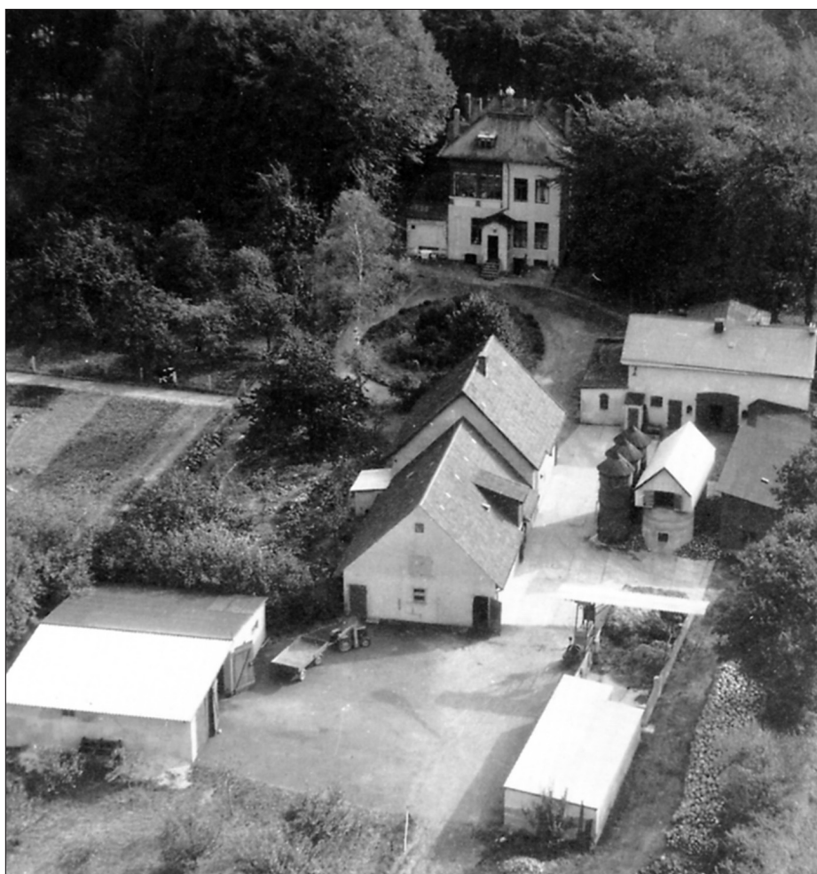
Abbildung 10: Hof Freienfelde, Wirtschaftsgebäude und Villa
