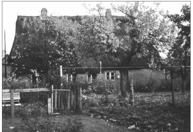
Abbildung 11: Instenkate vom Krögerhof an der Lofotenstraße 1968, kurz vor dem Abriss
