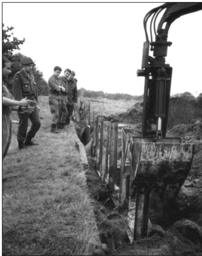
Abbildung 7: Rückbau des Handgranatenwurfstandes
