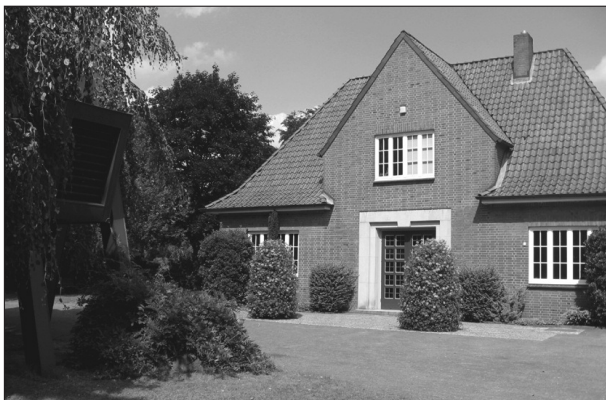
Abbildung 1: Friedhofskapelle mit freistehendem Glockenturm
