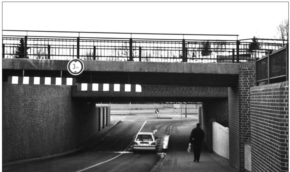
Abbildung 16: Der Tunnel, Blickrichtung Doberaner Weg. Foto: Annemarie Lutz 2004
