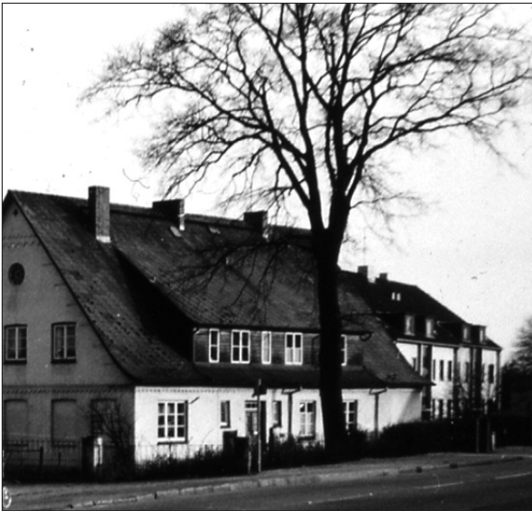
Abbildung 22: Der zum Wohnhaus umgebaute Kätnerhof Hinsch wurde in den sechziger Jahren abgerissen. Die Eiche steht heute noch, Foto: Kurt Scheffer 1960
