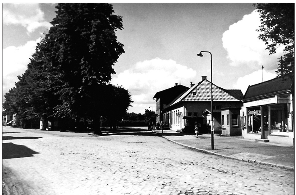
Abbildung 7: Bahnhofsgebäude mit Anbau der Bahnhofsgaststätte 1949; erstes Haus rechts einst Joh. Reincke - Licht, Kraft, Gas- und Wasseranlagen
