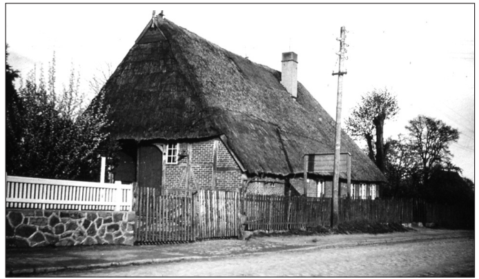
Abbildung 19: Ehemalige Schulkate; Kätner Claus Hinrich Gävers erwarb sie 1822 als Anbauerstelle. Foto um 1935, bald danach wurde sie abgerissen.
