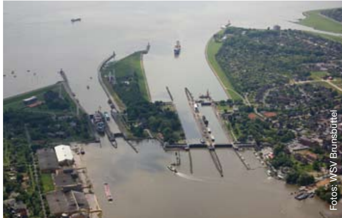
Die beiden großen Schleusenammern (rechts) sind defekt
