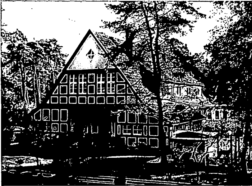
Das alte Schullandheim der Bosse-Realschule aus dem Jahre 1927, das 1958 durch einen Neubau erweitert wurde und jetzt durch einen umgestalteten Verbindungstrakt dem neuen Heimgebäude angegliedert wird.
