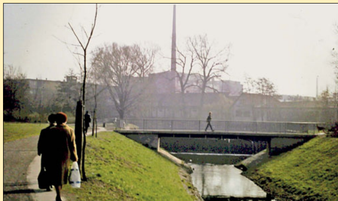
Eine neue Brücke verbindet Hogrevestraße und Hogrevestieg. Die Wandse in ihrem neuen Bett umfließt seit damals das Areal der Helbing-Fabrik. In Hintergrund sind die Fabrikgebäude und der Schornstein der Leonarwerke zu sehen.
