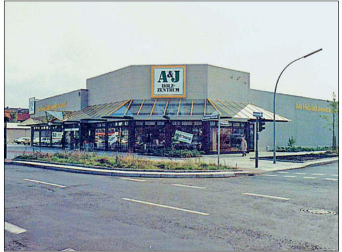
1985 zog in den großräumigen Nutzbau eine Filiale der Firma A & J Holz-Zentrum ein und bot ihr vielfältiges Programm zur Innenausstattung an.
