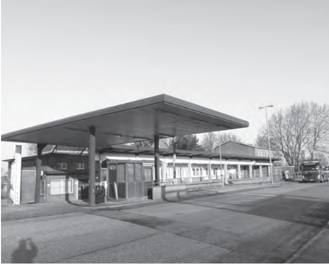
Die verlassene Zollstation Ernst-August-Schleuse. Nach dem Fall des Zauns ist der Zoll nur noch mobil im Hafen unterwegs. Was soll mit den alten Stationen geschehen? Foto: sic
