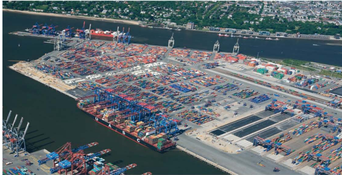
HHLA CTB im Sommer 2012 beim letzten Bauabschnitt | © HHM / M. Lindner
