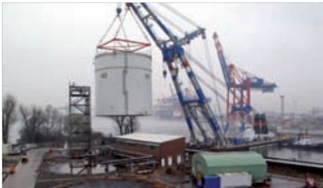
Für die Verladung musste der 520 Tonnen schwere Tank über ein Haus gehoben werden./The 520-ton tank had to be lifted over a building in order to be loaded.
