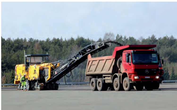
Alter, aufgebrochener bzw. abgefräster Asphalt wird wieder verarbeitet. Reclaimed asphalt, broken or ground off existing road surfaces will be recycled.
