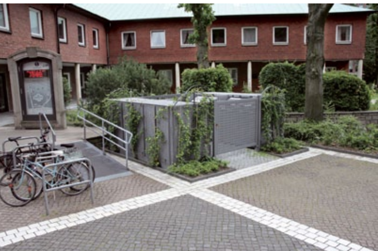
Der neue Abfallsammelplatz in unmittelbarer Nähe zum Michel und zum Verwaltungsgebäude.
